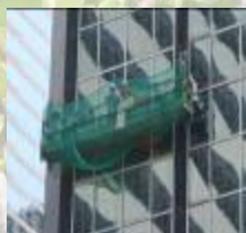
建筑署为入境事务大楼的玻璃幕墙进行翻新工程
