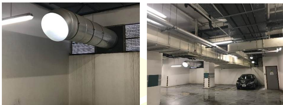
在顺利纪律部队宿舍安装的日光管道
