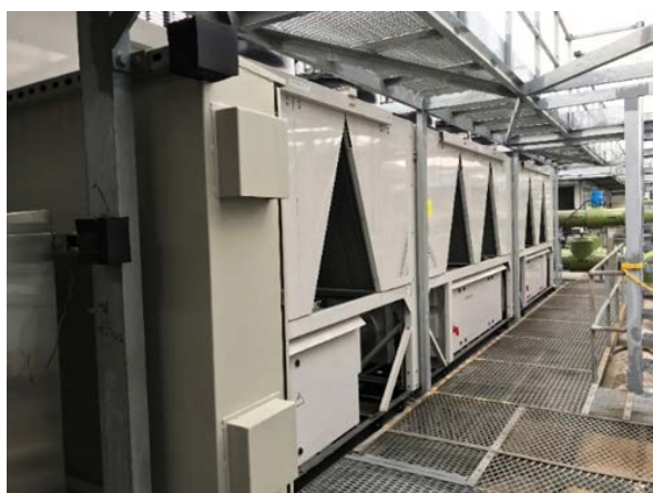
更换长沙湾政府合署大楼的制冷系统
