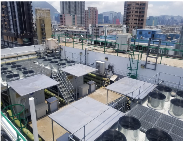
更换土瓜湾政府合署气冷式制冷机及冷冻水泵
