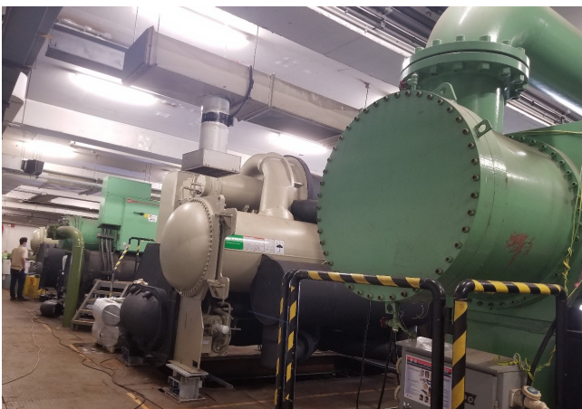
更换金钟道政府合署海水水冷式制冷机
