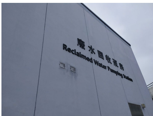
港珠澳大桥香港口岸的废水回收泵房
