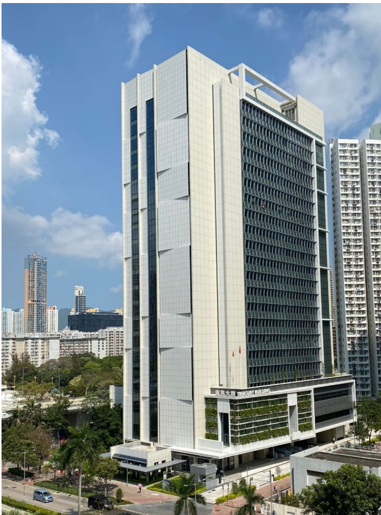
位于长沙湾的库务大楼属新联用大楼工程项目。
