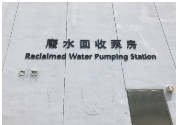
港珠澳大桥香港口岸的废水回收泵房
