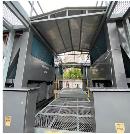
在大埔政府合署更换具备变速驱动节能器的气冷式制冷机及冷冻水泵
