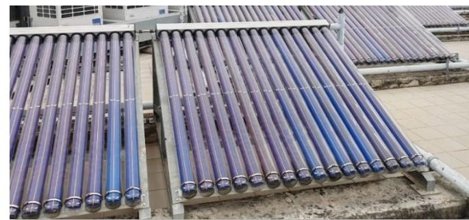
香园围边境管制站的太阳能热水加热系统
