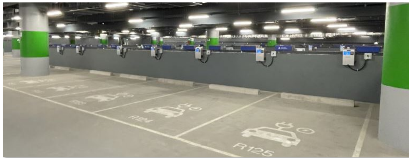
香园围边境管制站公众停车场的电动车充电器
