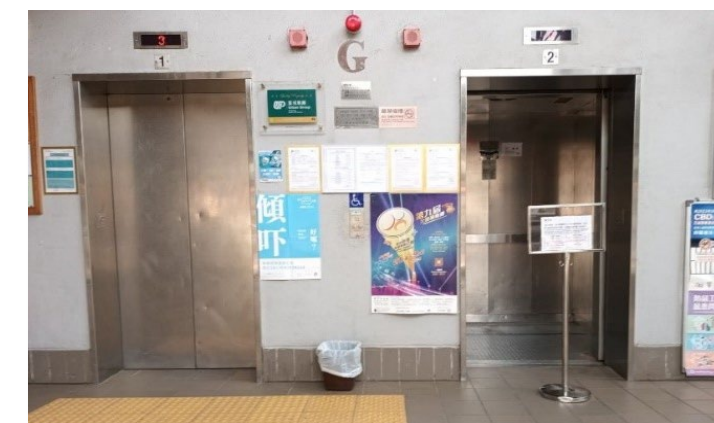
大兴政府合署善用升降机的使用时间
