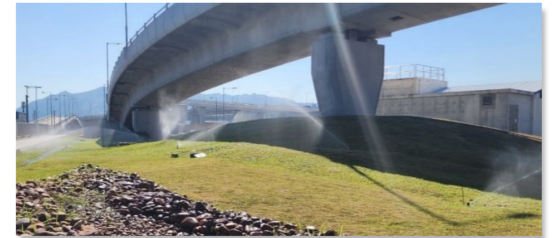
港珠澳大桥香港口岸以雨水回收系统进行灌溉
