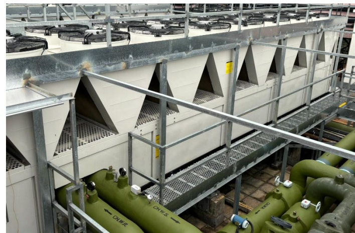
为荃湾政府合署更换具备变速驱动节能器的制冷机
