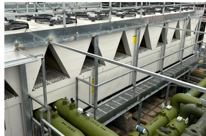
為荃灣政府合署更換具備變速驅動節能器的製冷機
