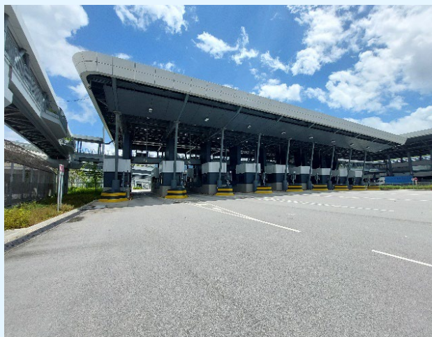
香園圍邊境管制站 貨車檢查亭(入境)
